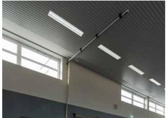
zusätzlich, da die Schallenergie in den Deckenhohlraum passieren kann. Hier wird sie von der nicht brennbaren, in Folie verschweißten Mineralwolle und deren spezifischem Strömungswiderstand weitgehend absorbiert.
