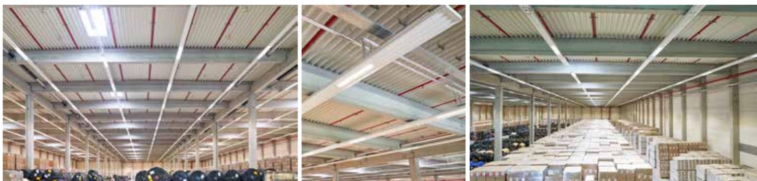
Die Auslegung der Sprinkleranlage nach FM Global erforderte besonders schmale Deckenstrahlplatten. Die Baulängen der Deckenstrahlplatten von bis zu 138 Meter konnten aufgrund des einzigartigen Doppelsammer-Konzepts realisiert werden.
